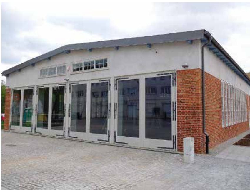
Fot. O-Bus-Betriebshof (Red.)
