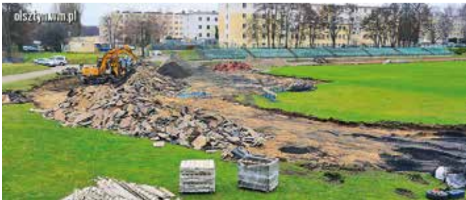
Fot. Renovierung des Stadions (Quelle: olsztyn.wm.pl)
