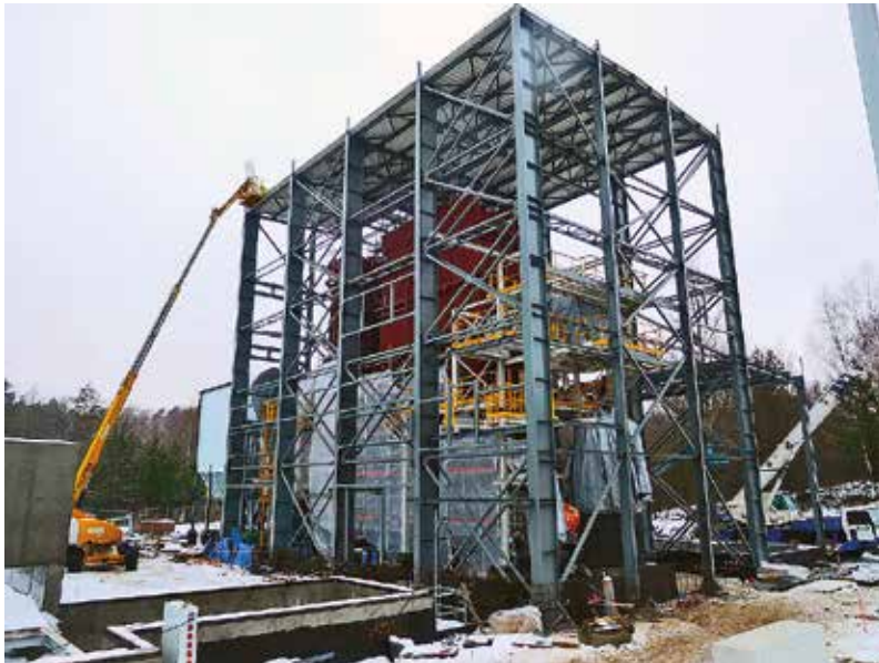
Fot. Kraftwerk im Bau (DK)
