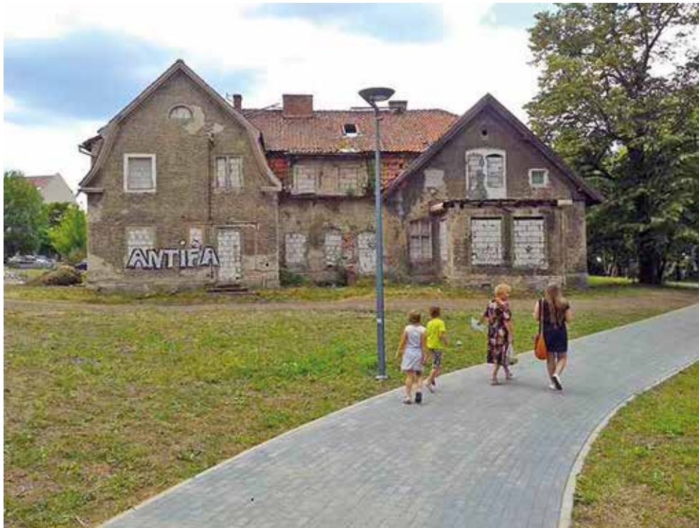
Fot. Gebäude vor der Renovierung (gazetaolsztynska.pl)
