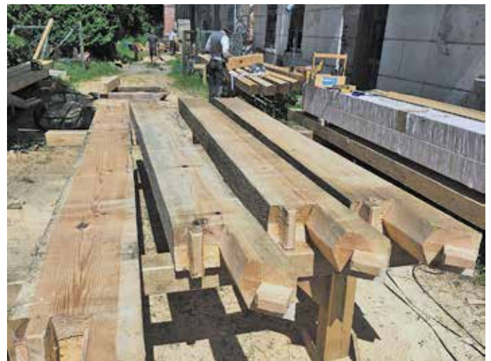
Fot. Geometrisch komplizierte Verbindungen am Kopf der liegenden Stuhlsäulen (Paul Neumann)
