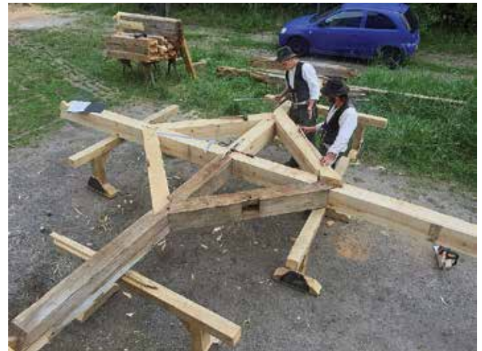
Fot. Probefügen des Binderkranzes am Abbundplatz (Paul Neumann)
