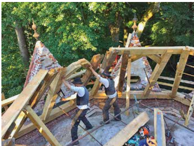
Fot. Aufrichten der liegenden Stuhlrahmen (Paul Neumann)
