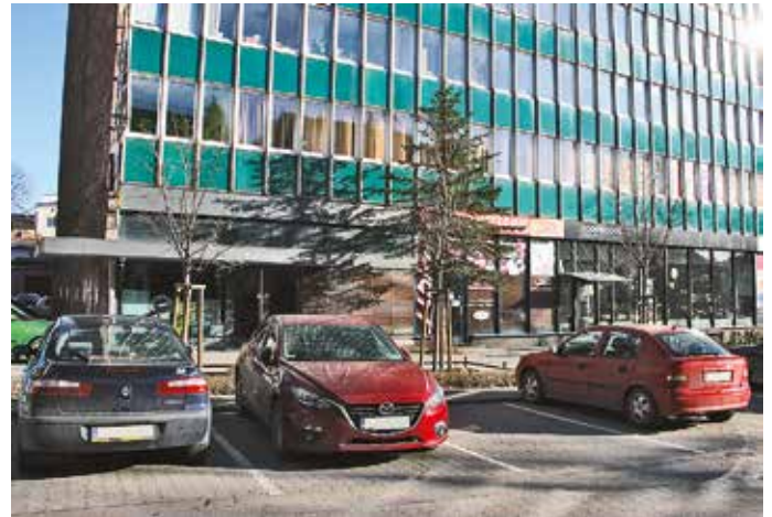
Fot. Bürohochhaus in der Kaiserstr. (GS)
